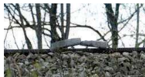
Żelbetonowa przeszkoda, która leżała na torach
