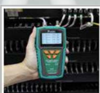
pomiar długości przewodu; lokalizacja punktu przzerwania
