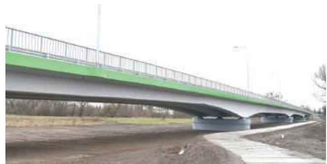
Nowy most na rzece Wieprz w Trawninkach ma ok. 230 metrów długości i ponad 13 metrów szerokości
