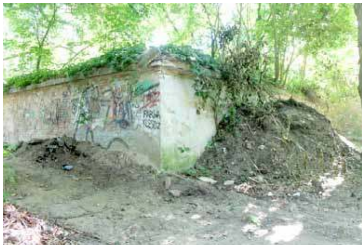
Do podziemnej części budowli prowadziły zniszczone biegi schodowe
