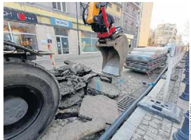
Pierwsze prace na Wigury to montaż tymczasowego wodociągu
