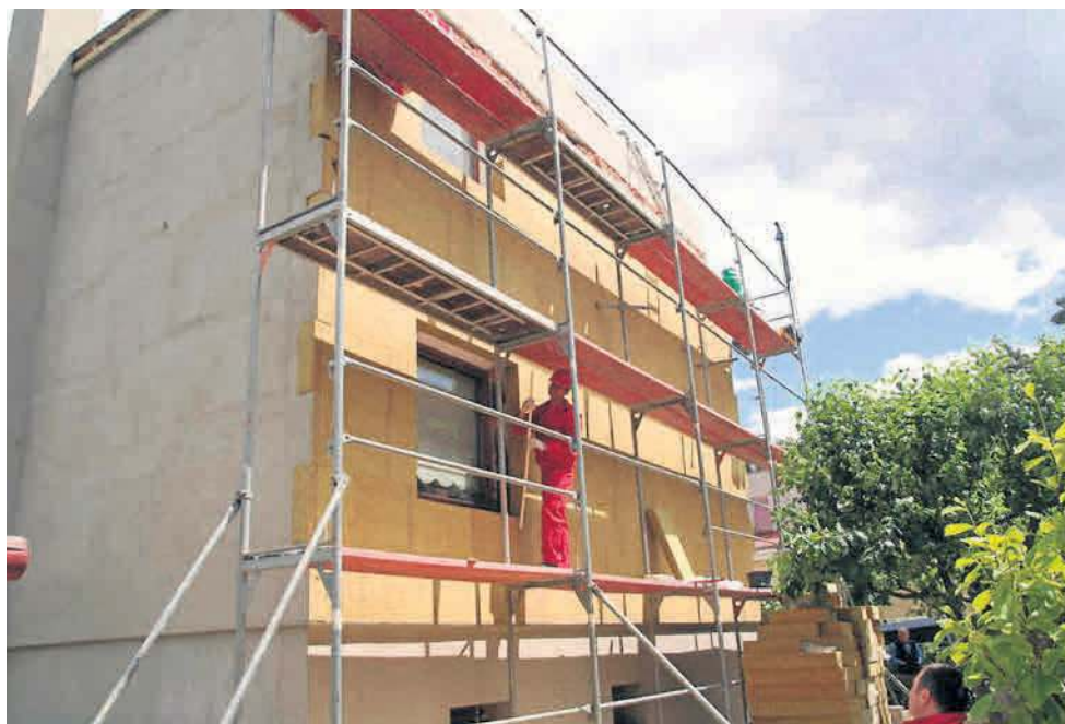
Najlepsze efekty daje termomodernizacja kompleksowa
