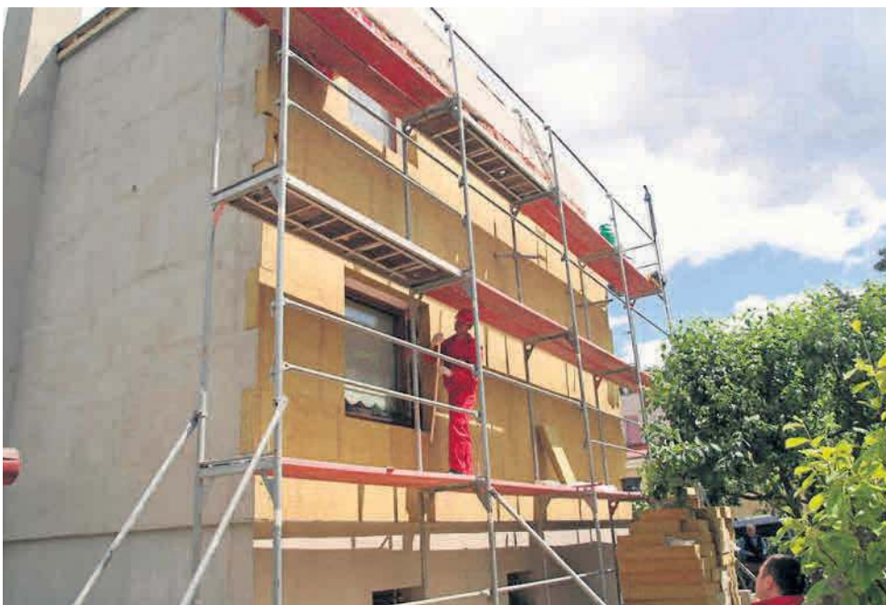
Najlepsze efekty daje termomodernizacja kompleksowa
