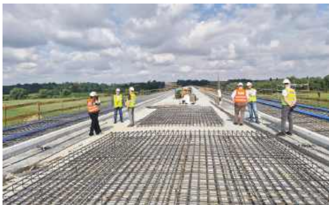
■ Most powstaje w ramach inwestycji wartej ponad 350 mln zł. Oprócz samej przeprawy budowany jest także 2,7-kilometrowy odcinek drogi, który połączy Grzegorzowice z Ciechowicami
