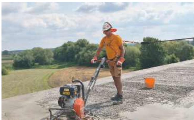
■ Wysokie temperatury wpłynęły na harmonogram prac. Przy największych upałach wykonawca musiał czasowo wstrzymać betonowanie oraz część robót bitumicznych.
