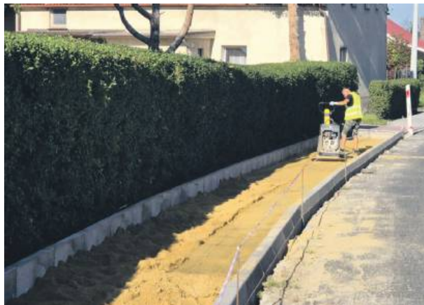
Trwa budowa chodnika w Gołostowicach
