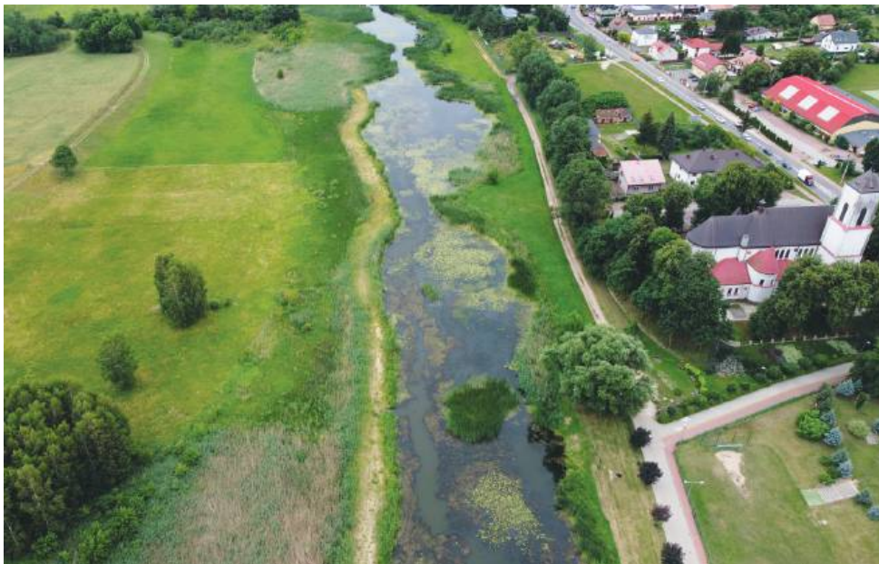
Tafla Jeziora zostanie poszerzona od kościoła w Wieliszewie w kierunku Rezerwatu Łęgi Wieliszewskie
