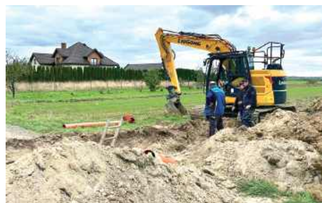
W gminie Aleksandrów rozpoczęła się kolejna inwestycja: - Prowadzimy rozbudowę sieci kanalizacyjnej i wodociągowej w Aleksandrowie. Drugim po stronie północnej i południowej - potwierdzają urzędnicy. Cały czas trwa także gruntowna modernizacja budynku Urzędu Gminy w Aleksandrowie
