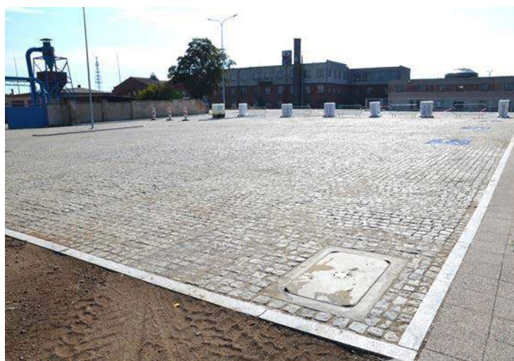
Parking przy ulicy Towarowej.
