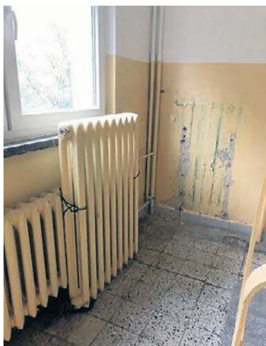
Kaloryfer usunięty ze ściany na klatce schodowej
