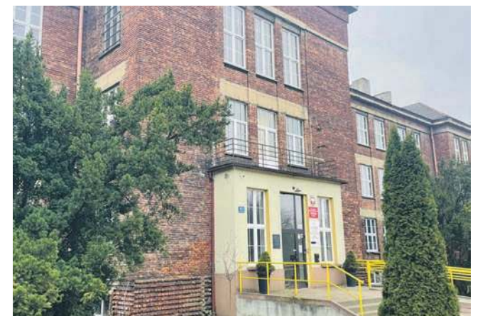
Budynek dawnego LO w Sierszy. Ostatnim jego najemcą była prywatna szkoła podstawowa Edison
