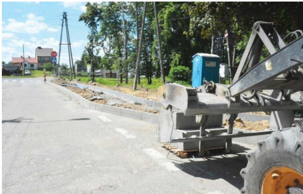
Budowa ścieżki rowerowej przy ulicy Sienkiewicza, która dalej będzie się łączyła z wybudowaną przy ulicy Baltazara
