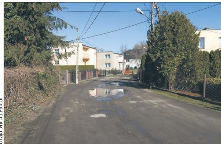
Trwają przygotowania do przebudowy ulicy Zakole
