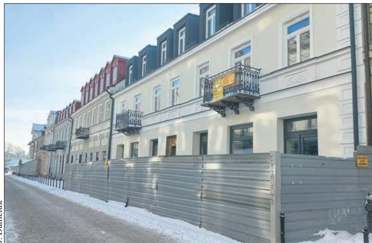
Przebudowywana kamienica przy ul. Grodzkiej 8
