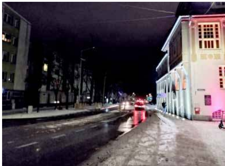
Po lewej przejście dla pieszych z uszkodzonym oświetleniem
