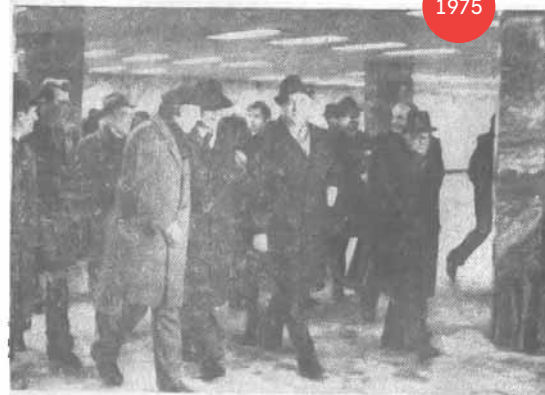
Na zdjęciu: Edward Gierk, Piotr Jaroszewicz i Henryk Jablonski zwiędają podziemne przejście nowego dworca. CAF — Szyperko — telefote
