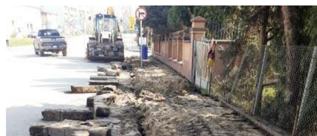
Ruszyły prace na ul. Sienkiewicza
