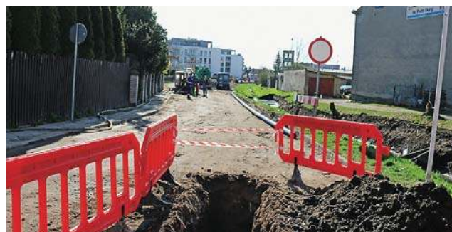
Miejsce prowadzonych prac ziemnych
