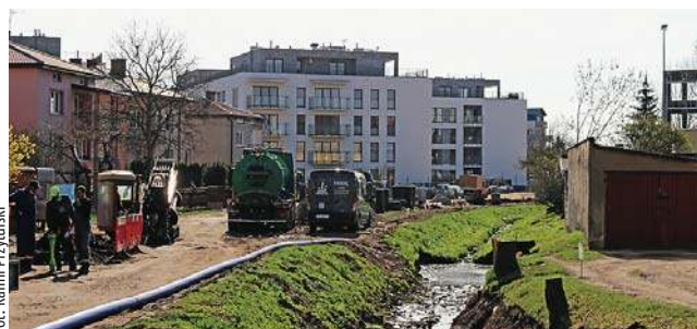
Ulica Piotra Skargi w trakcie prowadzonych prac i przepływająca obok rzeka Seracz
