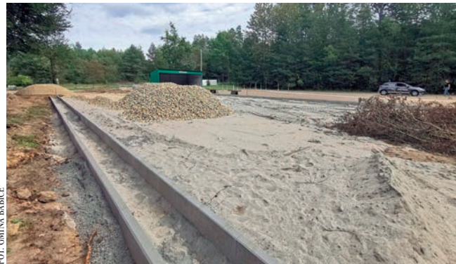
W ośrodku sportowym przy ul. Wieczystej trwają prace ziemne
