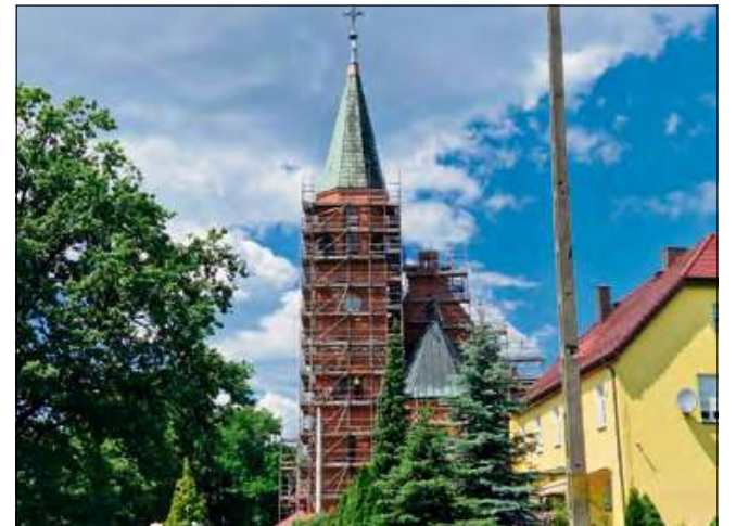
Prace związane z renowacją elewacji mają się zakończyć w sierpniu.
