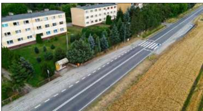
W Żywocicach przy ulicy Ligota wykonane zostanie nowe, dedykowane oświetlenie na przejściu dla pieszych na drodze krajowej nr 45.
