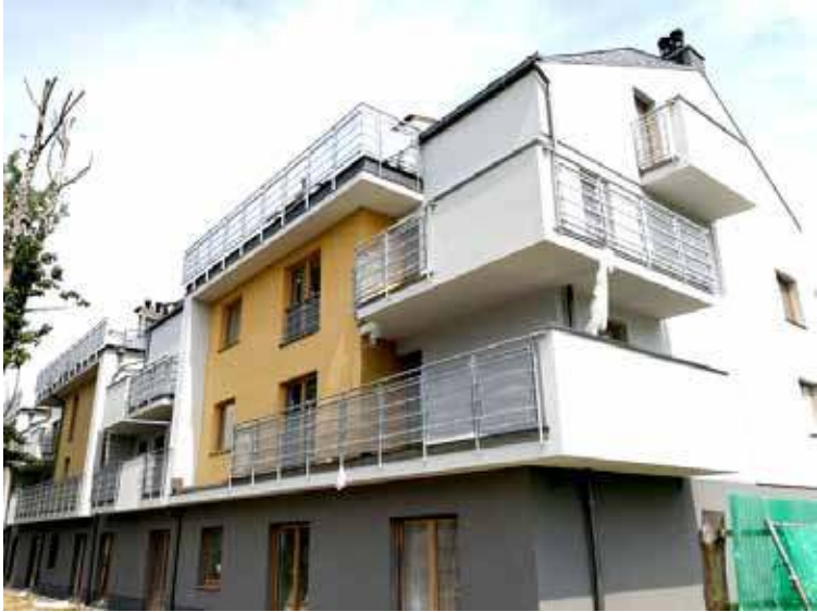
W tym roku spółka ma rozpocząć budowę budynku, w którym znajdować się będą 24 mieszkania
