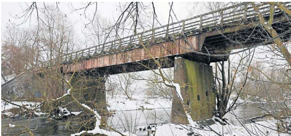
Stary most na Drwęcy między Kaszczorkiem i Złotorią będzie jednak remontowany
