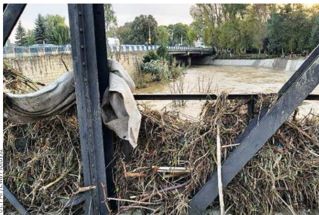
Zniszczenia po powodzi w Kłodzku
