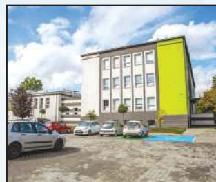
■ Termomodernizacja i zagospodarowanie terenu wokół ZSP w Rydułtowie 3,3 mln zł
