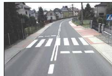
■ Modernizacja ul. Mickiewicza i Korfantego w Lubomiu 7 mln zł
