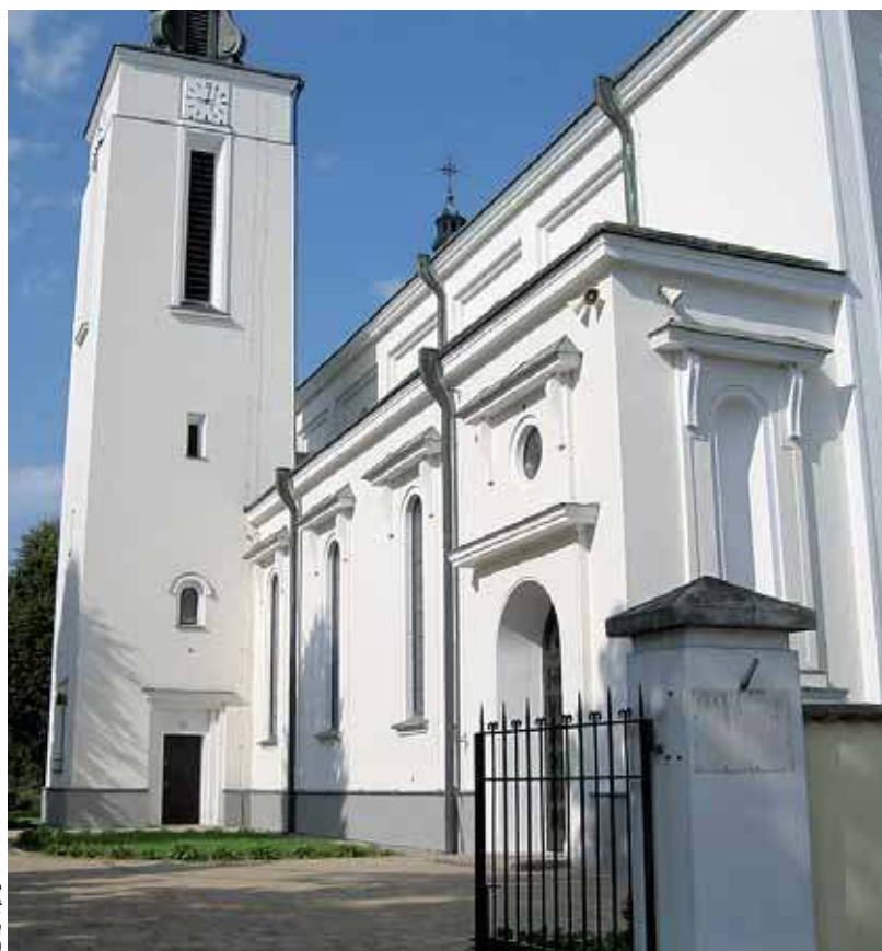
Parafia w Jabłonninie wykonała remont elewacji kościoła (fot. arch. UMWM)
