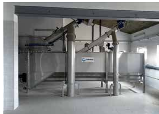
Zamontowany sitopiaskownik w nowym pomieszczeniu hali
