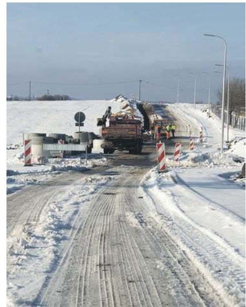
Trwa budowa drogi prowadzącej w stronę zamku w Rudnie
