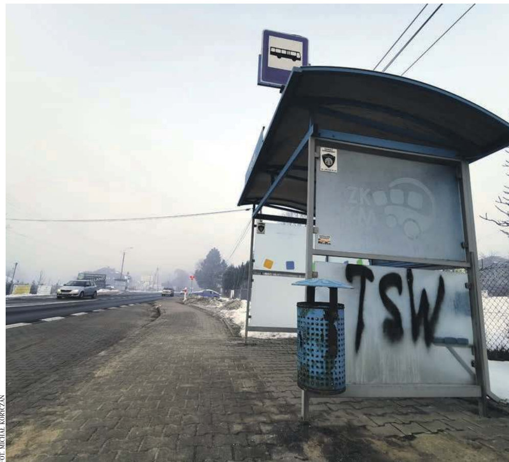
Przystanek autobusowy w Dulowej
