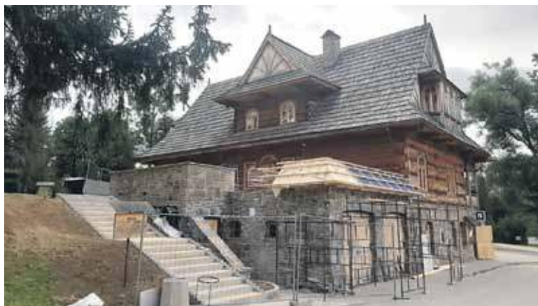
W Poroninie dobiegają końca prace remontowe, „Wańkówka” niebawem otworzy się dla mieszkańców i ich gości.
