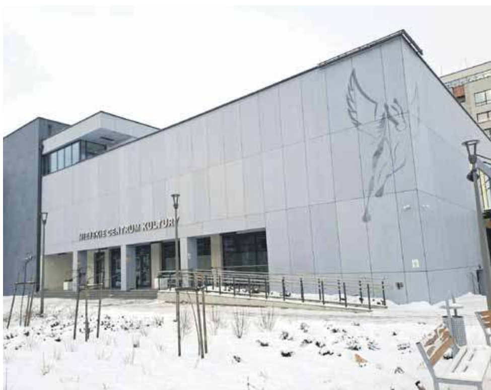
Czy budynek MCK już wymaga remontu?
