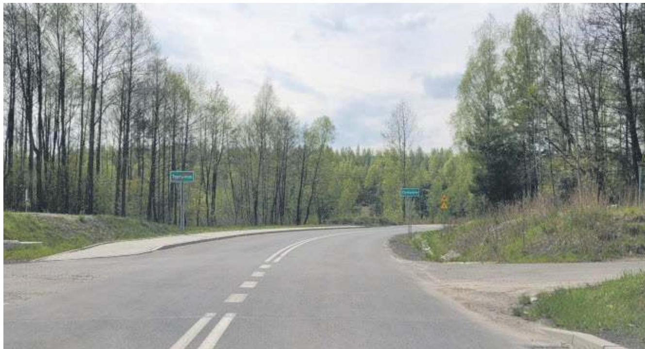
Powiatowy Zarząd Dróg w Chrzanowie ciągle nie rozstrzygnął przetargu na wykonawcę swojej największej tegorocznej inwestycji
