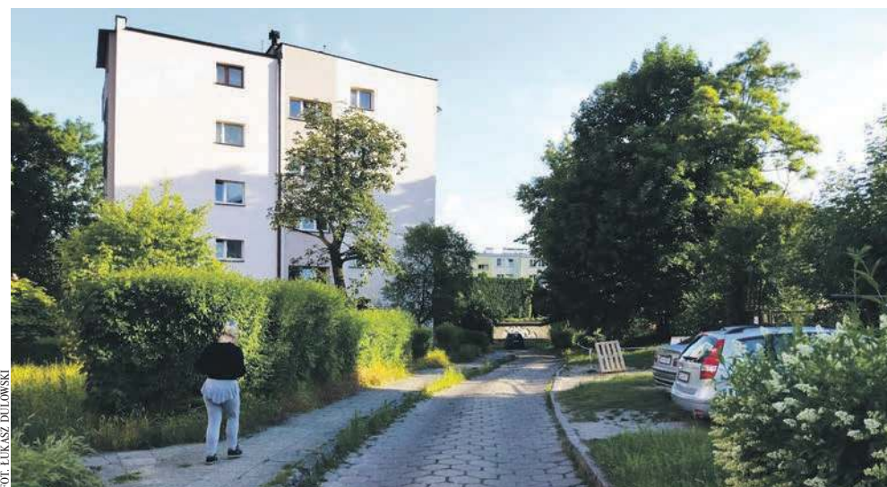
Rozpoczyna się przebudowa łącznika między Popieluszki i Broniewskiego na osiedlu Północ w Chrzanowie
