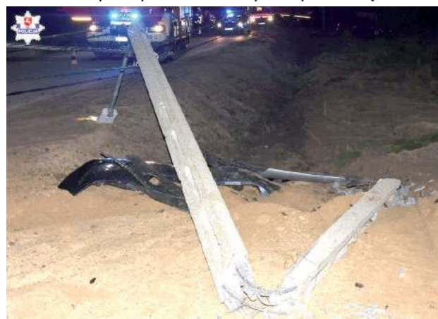
Według policji o nadmiernej prędkości auta może świadczyć siła, z jaką pojazd uderzył w betonowy słup trakcji elektrycznej, powodując jego pęknięcie
