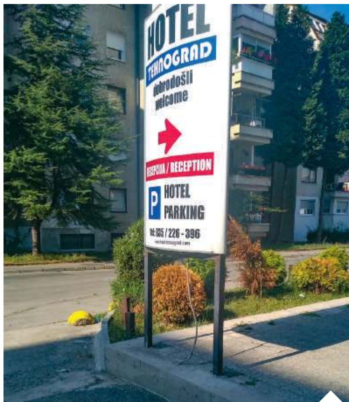
Robiąc podświetlenie szyldu, robotnicy puścili kabel nie po słupkach, na których szyld stał, lecz między nimi, tak że kabel stał się specyficzną pułapką na psa | fot. Jarosław Molga/Gazeta Polska
