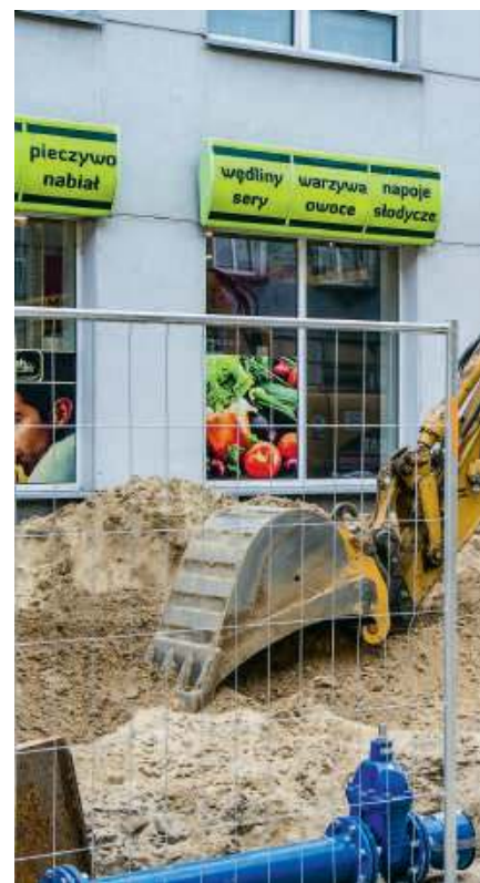
Obecnie modernizacja przebiega na odcinku od mostu
