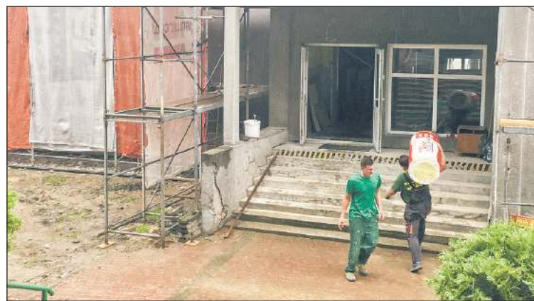
Robotnicy noszą wełnę mineralną używaną m.in. do docieplenia stropów.
