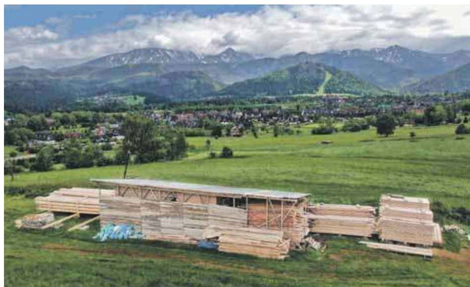
Zgromadzony na Bachledzkim Wierchu materiał budowlany wyraźnie wskazuje na zamiar budowy.
