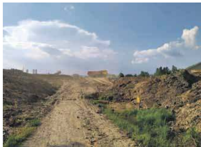
Tak wygląda wylot ścieżki rowerowej w stronę ul. Ludźmierskiej.
