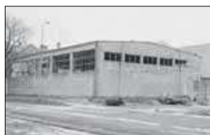
Tak powstawał budynek uczelni
