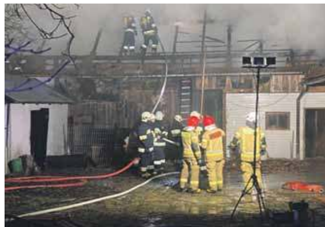
Spłonął niemal cały dach budynku gospodarczego.
