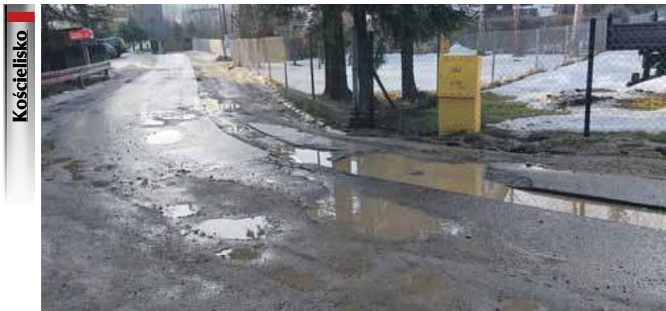
Stan ulicy Sobiechowska po przejściu gazowników doprowadza mieszkańców do szewskiej pasji.
