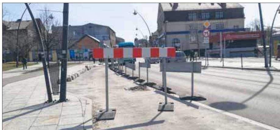
Rynek odNowa i centrum przesiadkowe też odNowa
