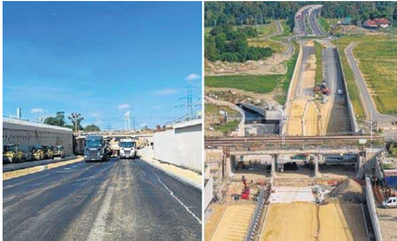
W miejscu, gdzie obwodnica przechodzi pod linią kolejową, drogowcy kładą pierwsze warstwy nawierzchni jezdni Fot. GDDKiA
