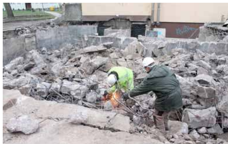
Pracownicy wycinają elementy zbrojeniowe dawnego składu węgla
