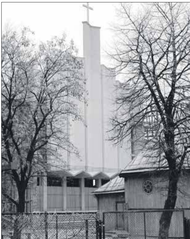
Lata 80. Po prawej stronie u dołu widać drewniany kościół tuż przed rozbiórką. Nowy był wtedy w budowie
