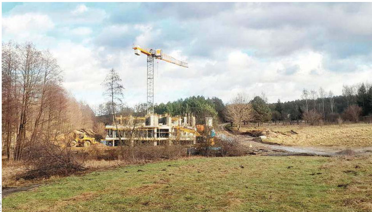
Kolejny apartamentowiec powstaje nad brzegiem jeziora przy drodze z Łupstycha do Słonecznej Polany
