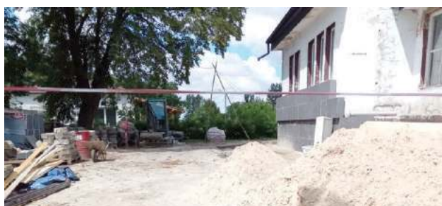
W jednej z otwartych studzienek kanalizacyjnych przy bibliotece natrafiono na kości.
