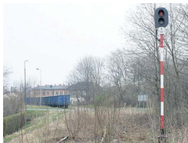
Część infrastruktury linii Strzelin - Kondratowice jeszcze działa
