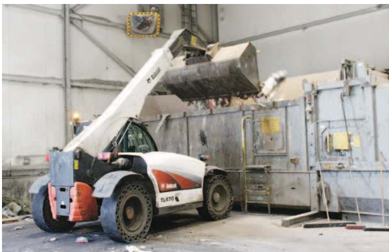
Na początku linii sortowniczej, worki ze zmieszanimi odpadami są rozrywane w specjalnym urządzeniu
