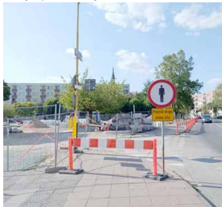
Przejście dla pieszych na Placu Wolności zostało zamknięte na okres ok. dwóch miesięcy
