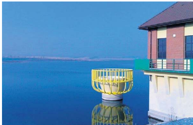
Zbiornik Włodzienin oficjalnie przeszedł w ręce Wód Polskich. To otwiera drogę do modernizacji obiektu.
