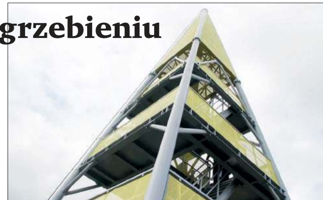
■ Wieżę widokową w Pogrzebieniu wykonano z elementów metalowych na planie kwadratu w formie ostrosłupa. Z obiektu można zobaczyć m.in. Tworków, Bieńkowice, Sudety, Pasma Jeseníków, zbiornik Racibórz, Sudół czy Studzienną. FOT. DAWID MACHECKI
