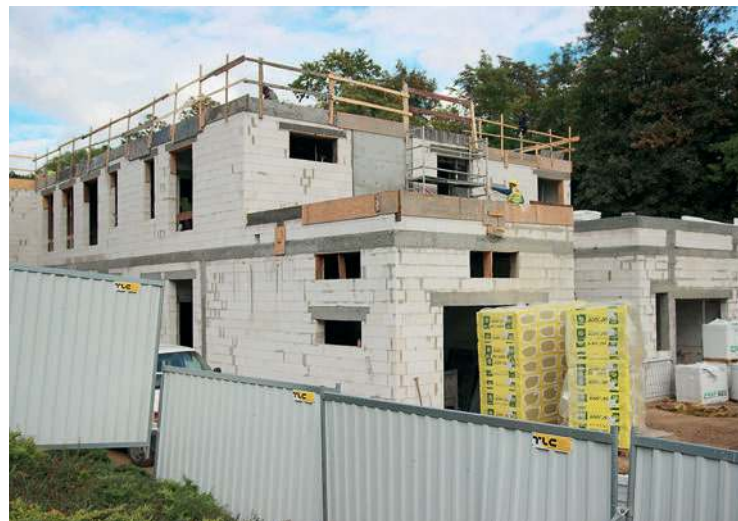
Obecny etap prac budowlanych
