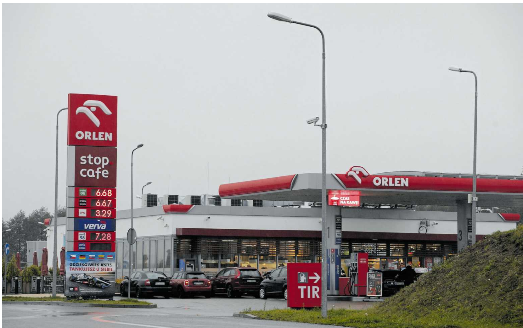
• Sople, 29 października 2023. Stacja paliw Orlen przy trasie S7
